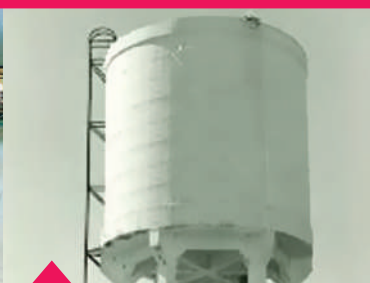
Penampungan Air Beton
